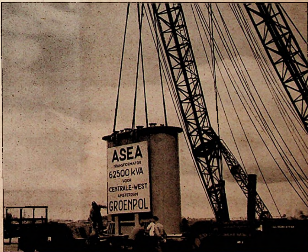
De aanvoer van de verschillende onderdelen voor de centrale gaf grote moeilijkheden. Deze foto geeft een beeld van het transport van een transformator, met een bok via het IJ.
